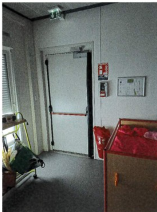
porte de secours de l'Algéco
