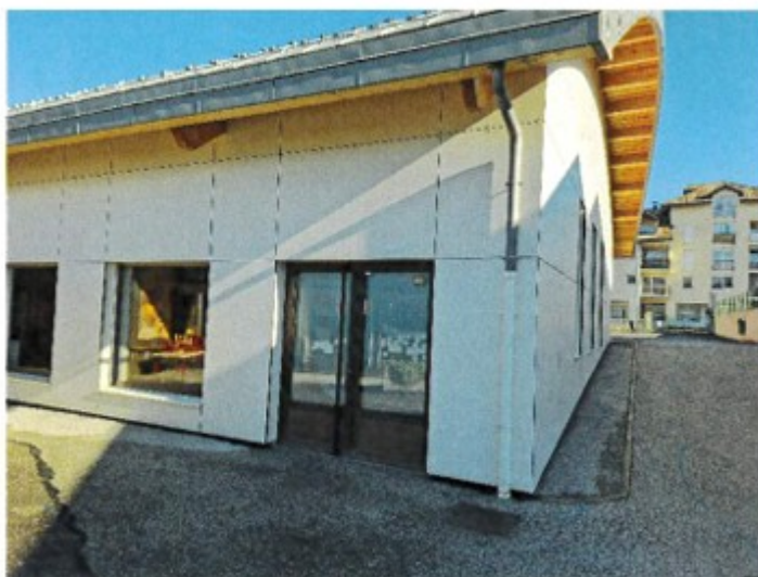
Portes d'entrée de la salle de motricité
