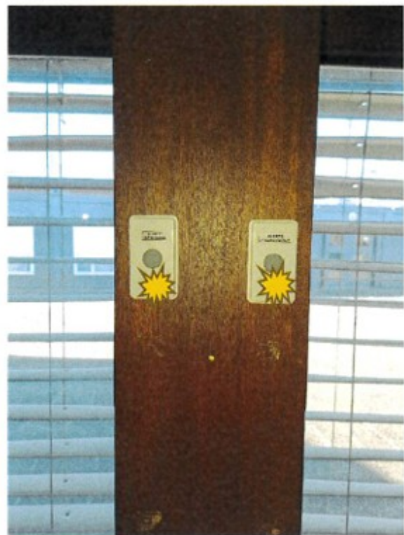
Boitier d'alarme confinement ou intrusion dans chaque classe
