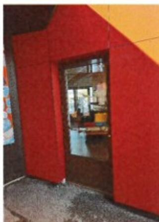
Accès vers le SAS d'entrée de l'école
