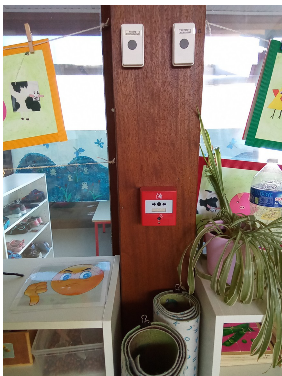
Boîtier déclencheur dans chaque classe
