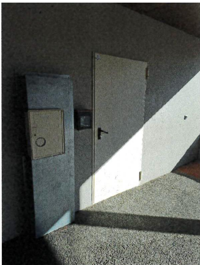
Porte d'entrée de la chaufferie
